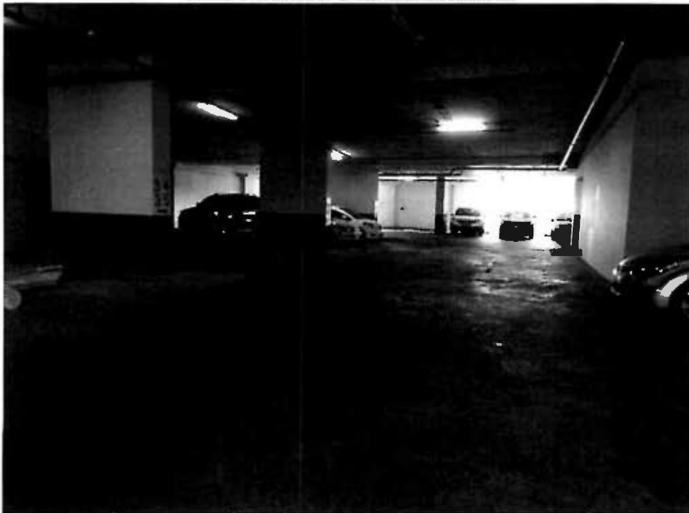
VISTA TÍPICA DEL ÁREA DE ESTACIONAMIENTOS Y ÁREA DE CIRCULACIÓN DEL NIVEL E-1 @ E-4
