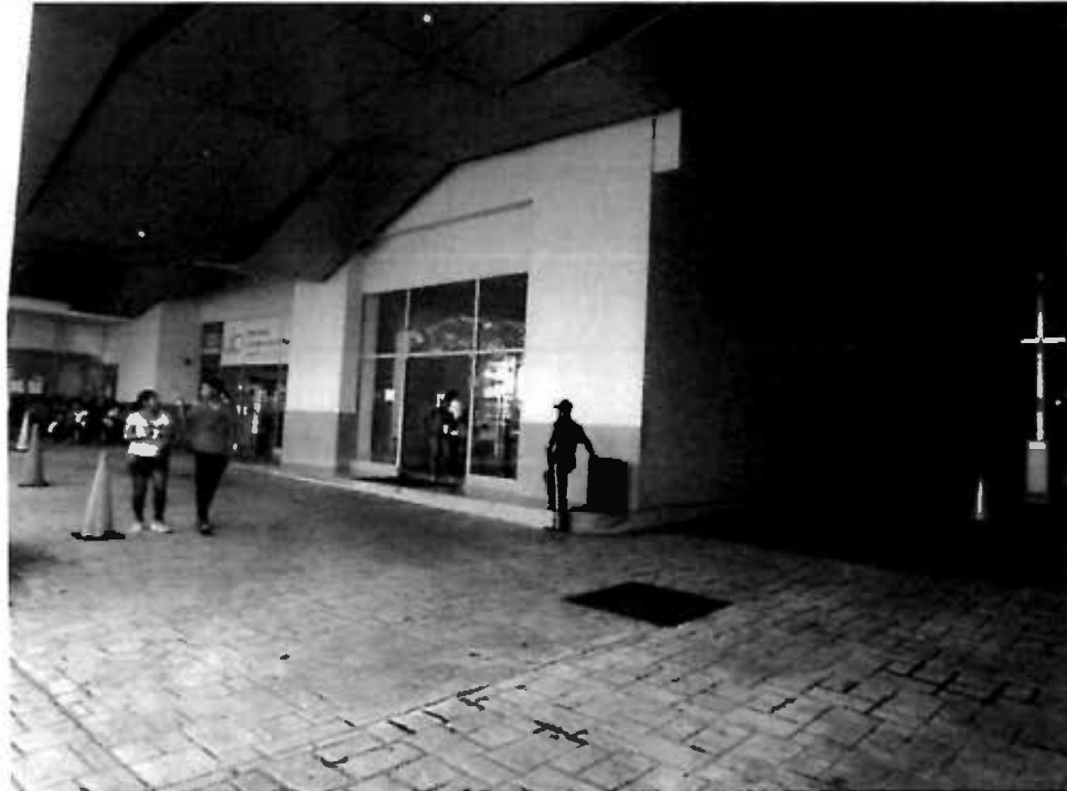
VISTA PARCIAL DEL ÁREA DE CIRCULACIÓN, OFICINAS Y ACCESO AL LOBBY DEL EDIFICIO
