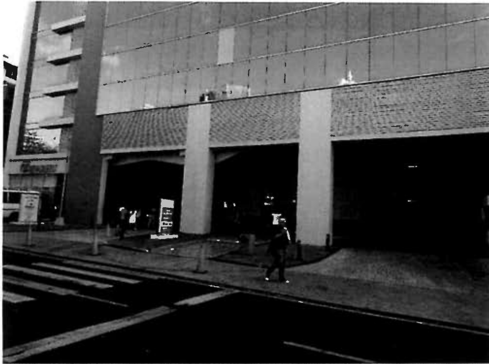
VISTA DE LAS RAMPA DE ACCESO Y SALIDA DE LA PUERTA COCHERA
