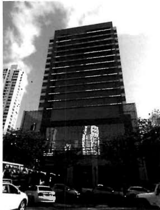
VISTA GENERAL DEL EDIFICIO UNICORP TOWER PLAZA, MOTIVO DE NUESTRA INSPECCIÓN
