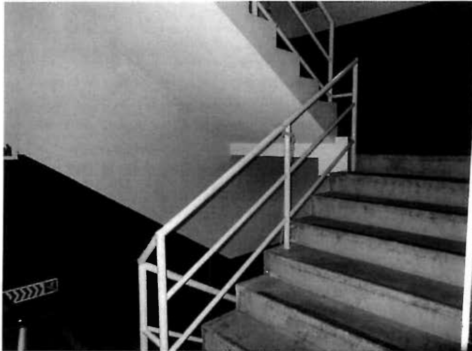
VISTA GENERAL DEL ÁREA DE ESCALERA DE EMERGENCIA
